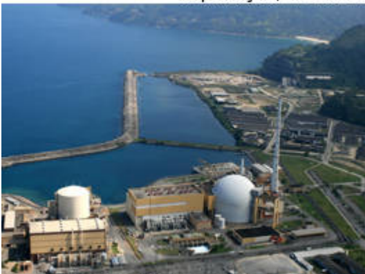
Construção de usinas nucleares em Angra foi aprovada em 1975
