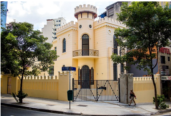
Castelinho da rua Apa, no centro de SP
