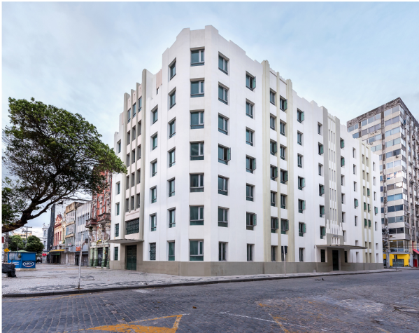
Sede da OAB-PE em Recife OAB-PE
