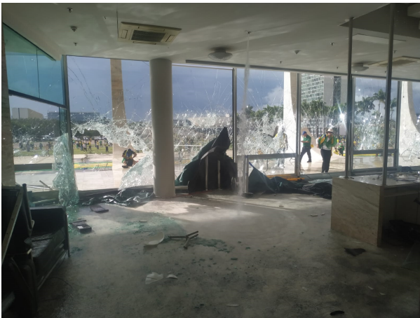
Interior do prédio do STF, em Brasília, depredado pelos vândalos terroristas
