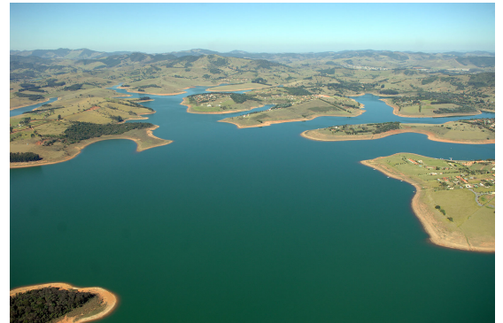
Represa de Jacaréi, do sistema Cantareira, um dos principais utilizados pela companhia de saneamento Sabesp
