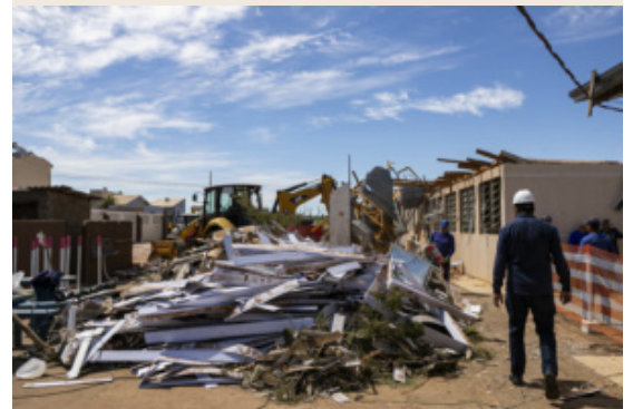
Colégio Rio Bonito do Iguaçu (PR) sendo reconstruído após tornado
