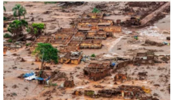
Tragédia da barragem de Brumadinho ocorreu em janeiro de 2019
